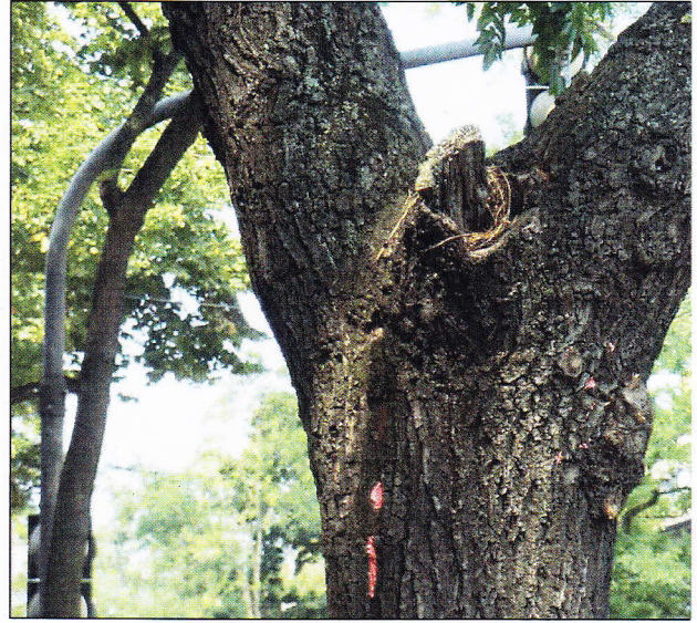
Abb. 26: . Faulstelle Kronenansatz Baum 215
