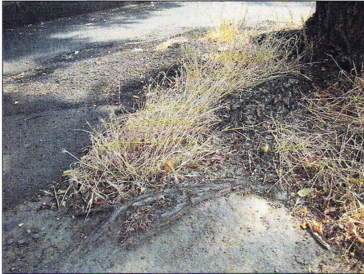
Abb. 21: Rindenschäden Wurzel Baum 9
